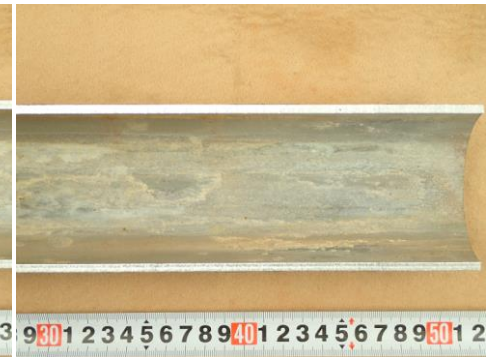
写真2-8 配管内面 拡大
