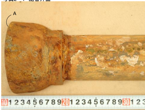
写真2-2 配管外面 拡大
